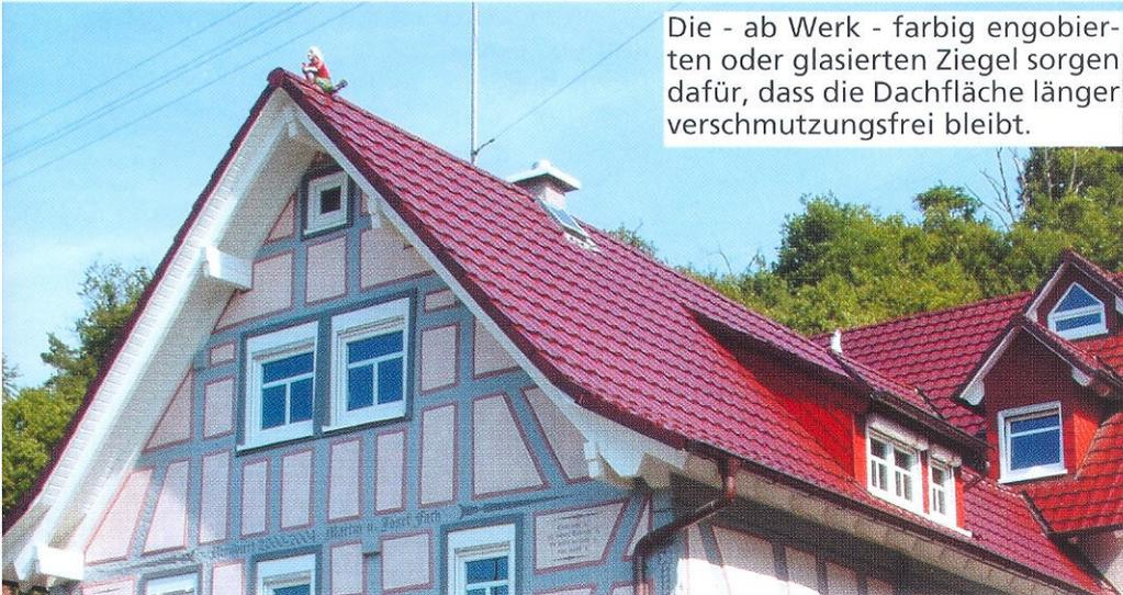
Die - ab Werk - farbig engobierten oder glasierten Ziegel sorgen dafür, dass die Dachfläche länger verschmutzungsfrei bleibt.
